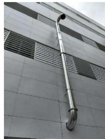
O ponto de saída do Tubo Quench deve ficar em área segura, afastado de janelas ou área onde possa haver circulação de pessoas, ainda que temporariamente. Deve-se instalar um aviso junto à saída do Tubo indicando a possível saída de gases e pequenas partículas. A saída do tubo deve ser protegida contra a entrada de água e possuir tela para evitar a entrada de pequenos animais.
